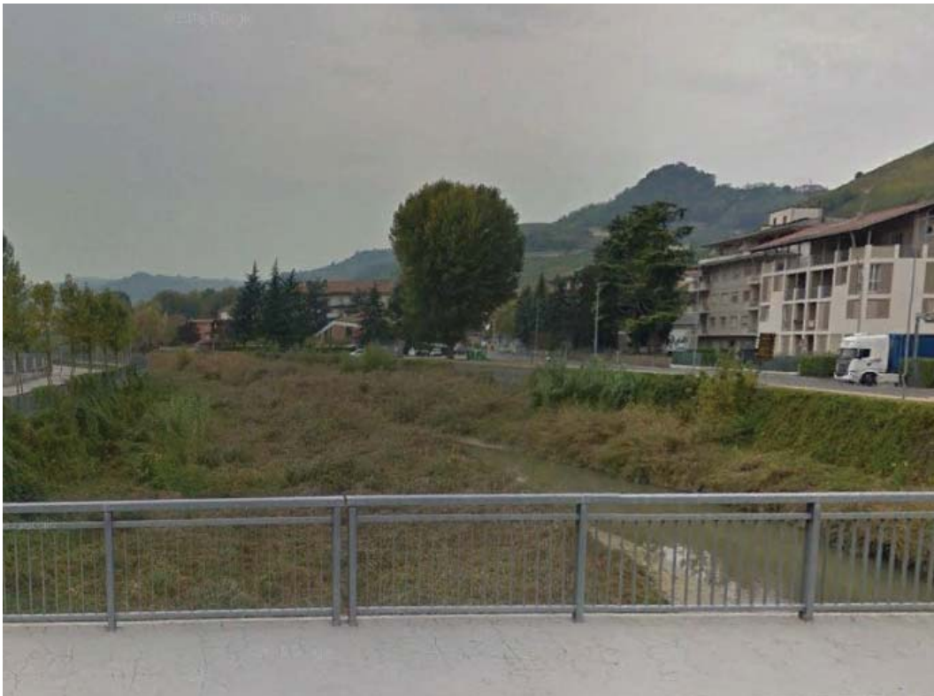
Figura 12. Tratto a monte del ponte di S. Stefano Belbo. Il tratto è stato rettificato e canalizzato; essendo la sezione ridotta rispetto a quella originale, per evitare che si riduca ulteriormente, la vegetazione presente deve essere periodicamente rimossa
