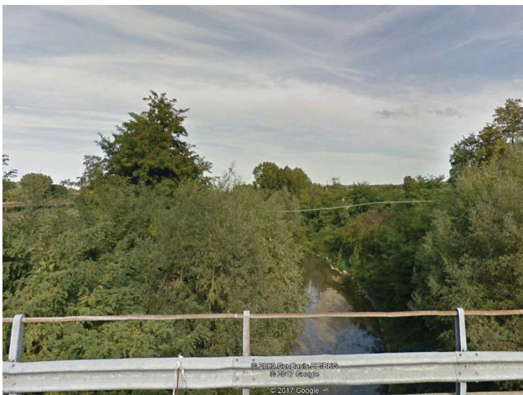
Figura 25. Ponte di Quartino (Calamandrana) lato a valle da sottoporre a gestione periodica della vegetazione arborea per un tratto di almeno 30 m
