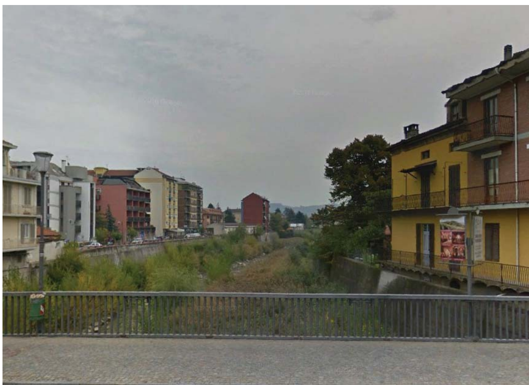
Figura 19. Tratto a valle del ponte di Canelli con alveo arginato da sottoporre a rimozione periodica della vegetazione
