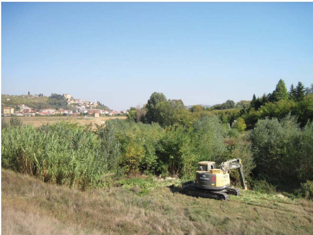
Figura 16. Cassa di espansione di Canelli con mezzi di manutenzione in attività per la riduzione della vegetazione nei tratti arginali
