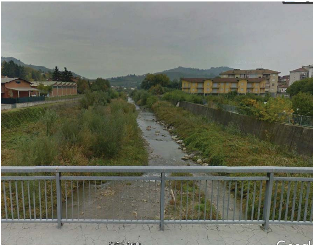
Figura 13. Tratto a valle del ponte di S. Stefano Belbo. Analogamente a quanto suddetto la vegetazione deve essere rimossa periodicamente per evitare una ulteriore riduzione della sezione utile dell'alveo
