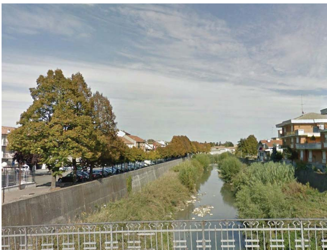
Figura 27. Lato a valle del Ponte di Via Roma a Nizza Monferrato; analogamente a Santo Stefano B. e a Canelli il tratto urbano è difeso mediante muri arginali. La vegetazione all'interno dell'alveo viene periodicamente gestita con tagli a raso
